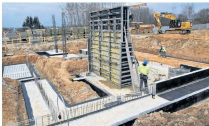
Rozpoczęło się wylanie fundamentów pod budynki Głównego Urzędu Miar w Kielcach.
