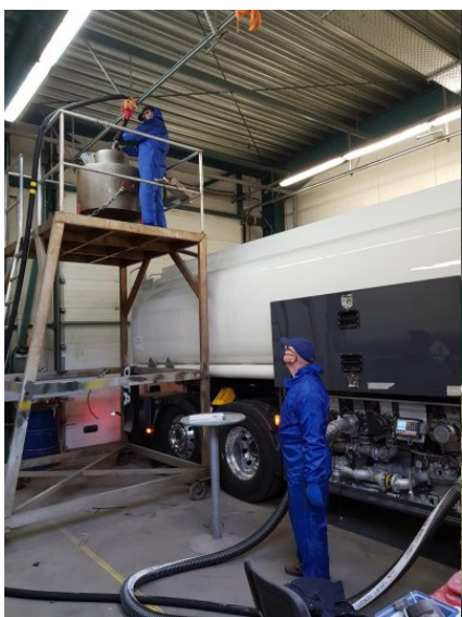
Legalizacja instalacji montowanej na autocysternie
